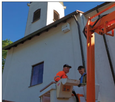
Mit dem Hubsteiger wurde der neue Mauerseglerkasten aufgehängt
